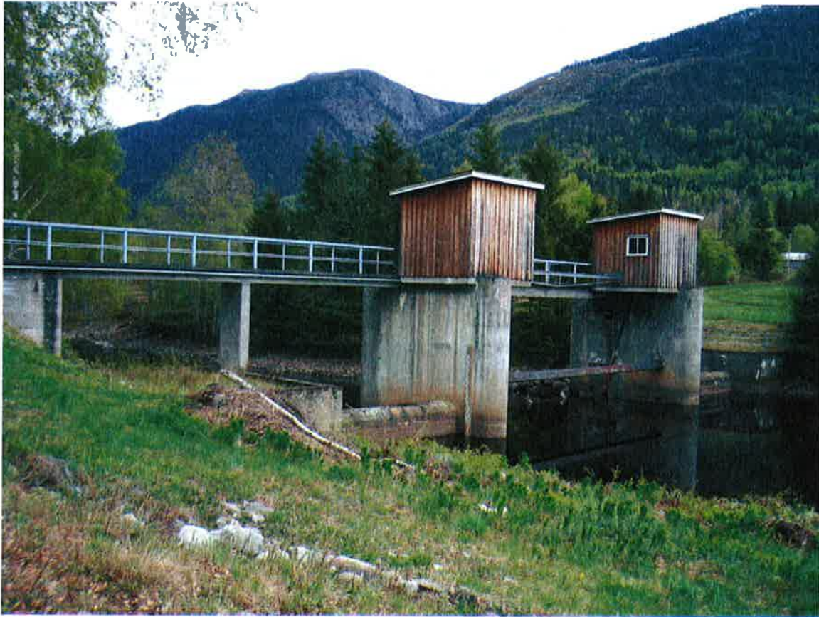
Figur 3-14 Eksisterende dam Hjartsjå bygges om til ren betong overløpsterskel
