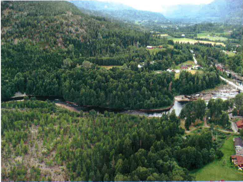
Figur 7-26 Ørvellaviften og Omnesfossen (til høyre). Bilde: Skagerak Kraft, 2008.
