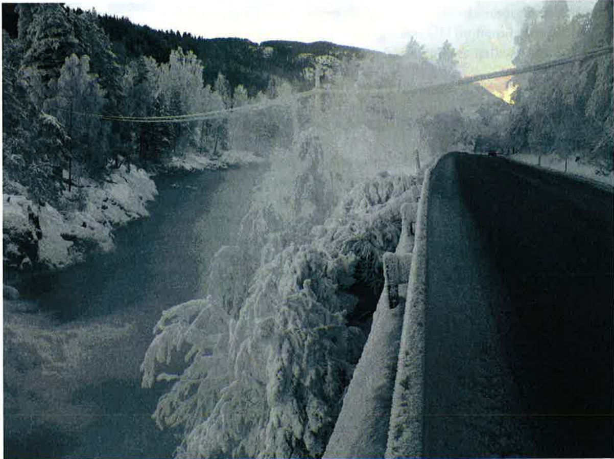
Figur 7-28. Frostrøyk og rim langs Hjartdøla. Bilde fra vinteren 2007/08 der det er frostrøyk langs Hjartdøla, og mye rim på trær og konstruksjoner i nærheten. Temperaturen var 15-20 kuldegrader. Vi ser at tåka og rimet begrenser seg til områdene nær elva, og har en vertikal utstrekning på 10-15 meter. Kilde: Skagerak Kraft.
