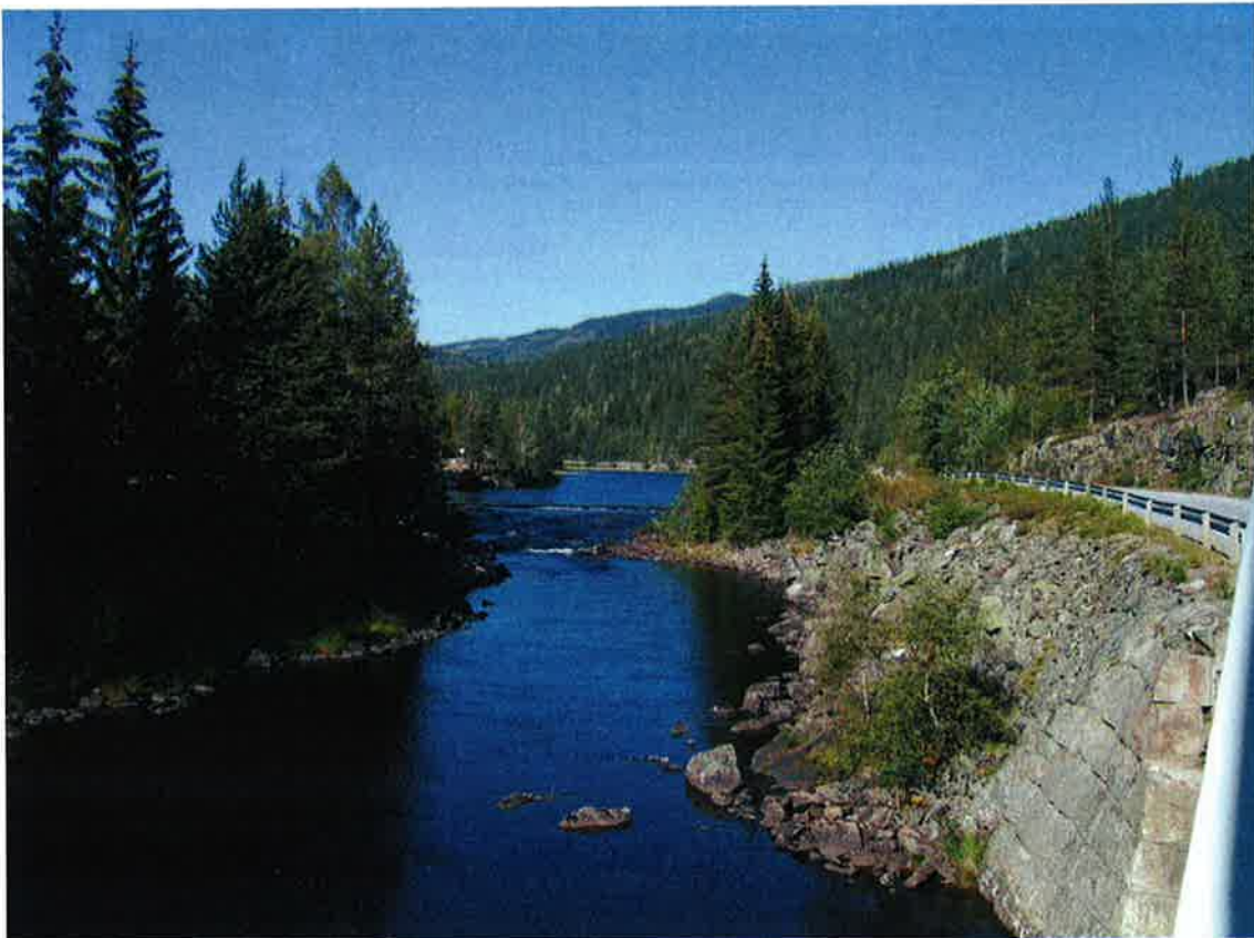
Figur 3-16 Eksisterende terskel Sønderlandsvatn (rives/flyttes)
